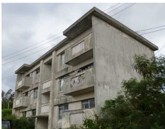
【老朽化した公営住宅】
